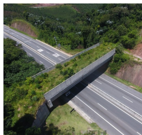
Figura - Viaduto de fauna implantado na Rodovia dos Tamoios com plantio de árvores sobre a estrutura.
