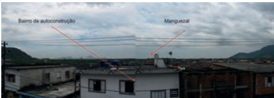
Figura 6.10. Bairro de autoconstrução construído sobre aterro na unidade Planícies Flúvio-Marinhas Urbanizadas
