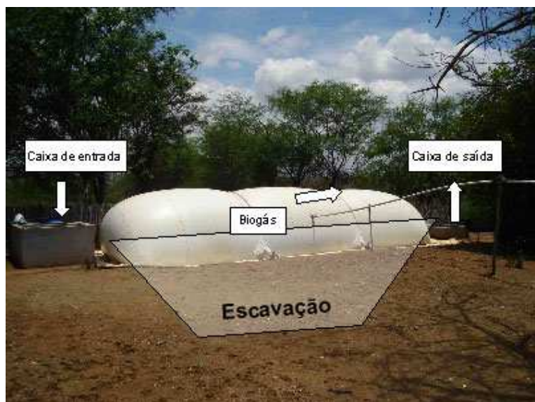
Figura 1: Digestor anaeróbio: Demanda de pequena área e de construção simples. (Fonte: http://www.redepeabirus.com.br . Acesso em 24/08/2014).
