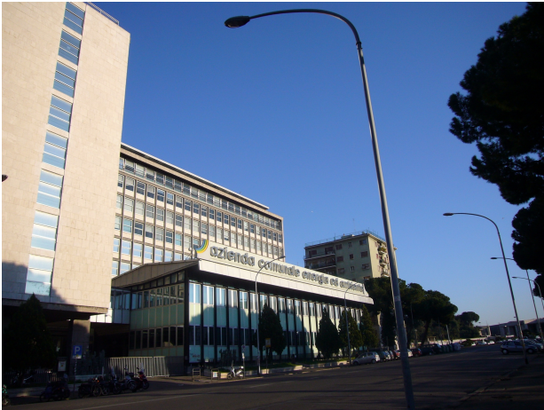
Immagine 9: Sede dell'Acqua Spa e dell'Acqua Ato2 a Piazzale Ostiense, Roma.
