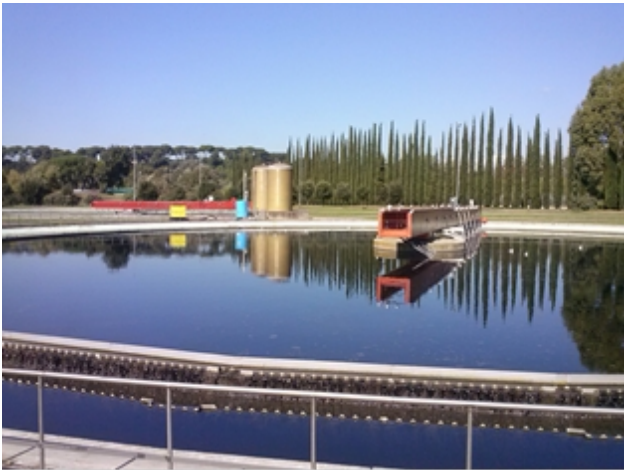
Immagine 12: Vasca di sedimentazione, depuratore Roma Nord, settembre 2014.
