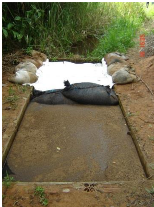
Figura 20 - Sistema de filtragem construído na manilha de acesso à piscicultura, com barreiras e mantas absorventes, turfa a granel, carvão ativado, e outros materiais Fonte: CETESB
