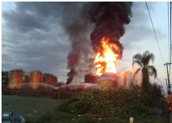
Figura 12 - Água de rescaldo do incêndio na Ultracargo atingindo lagoa contígua Fonte: CETESB
