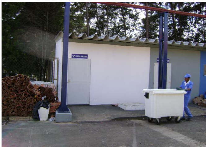
Figura 07 - Local de armazenamento externo de resíduos infectantes.
