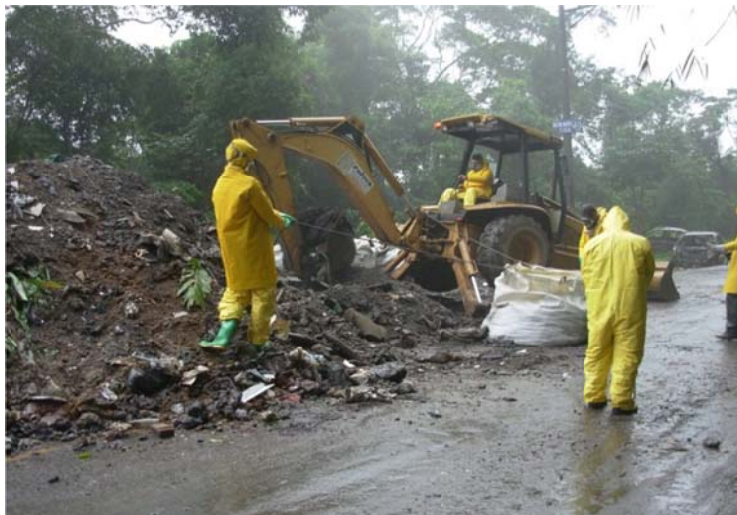
FIGURA 73 – Registro fotográfico da colocação dos resíduos em “big bags”. Fonte: CETESB - Companhia Ambiental do Estado de São Paulo (Banco de Imagem)
