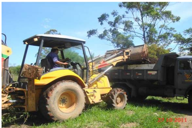
FIGURA 7 – Registro fotográfico da utilização de pá-carregadeira para retirada dos resíduos.
