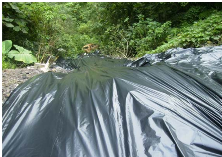
FIGURA 72 – Registro fotográfico do atendimento emergencial para reduzir ação de água de chuva sobre os resíduos. Fonte: CETESB – Companhia Ambiental do Estado de São Paulo (Banco de Imagem)
