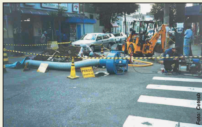
Ações emergenciais para controle do risco: exaustão, escavação e lavagens
