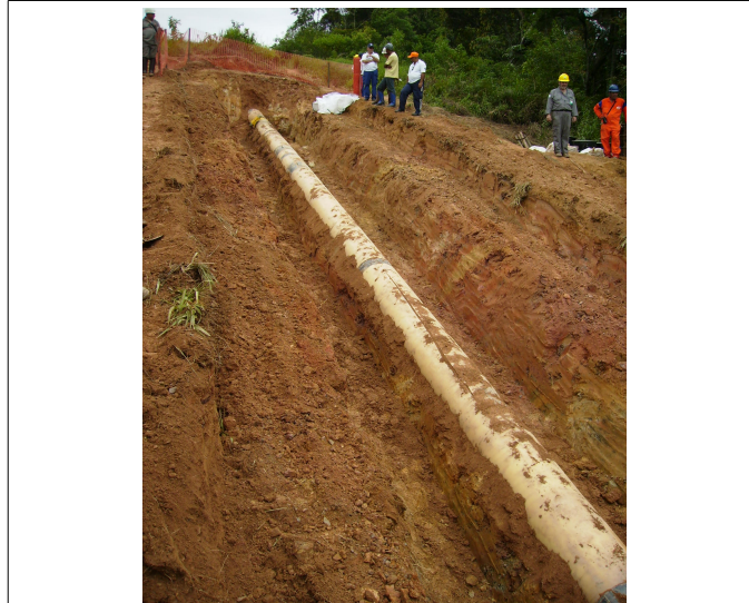
Foto 2 – Duto exposto para realização de reparo após vazamento de petróleo ao meio ambiente.
