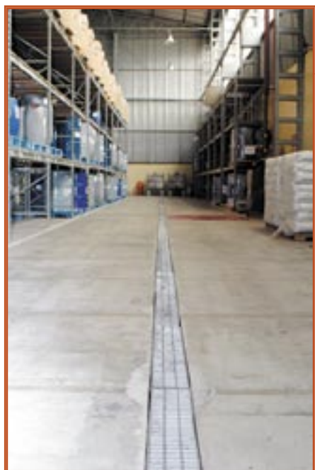
ÁREA DE ARMAZENAGEM: DETALHE DA CALHA DE EMERGÊNCIA PARA DRENAGEM DE LÍQUIDOS DERRAMADOS.
