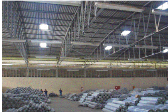
Foto 1 - Utilização de telhas translúcidas no galpão industrial - medida P+L com redução do consumo de energia elétrica
