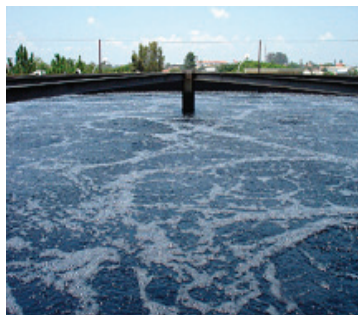
Fotos 12 – Tanques de equalização e de aeração do STAR
