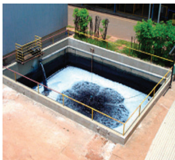
Fotos 12 – Tanques de equalização e de aeração do STAR
