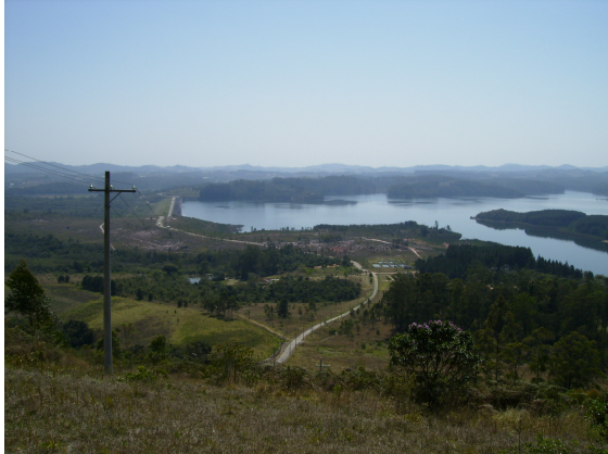
Barragem Ponte Nova
